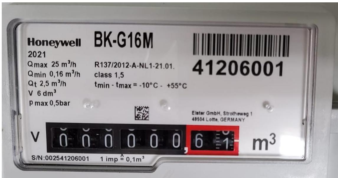
Fotografía 7. Vista de la placa de características del medidor de gas tipo diafragma, tamaño G16
