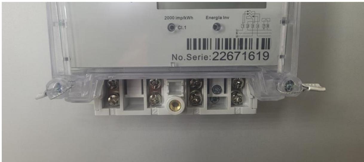
Fotografía 5. Vista (2) de los bornes del medidor de energía eléctrica marca HEXING, modelo HXE13ES, 3 hilos
